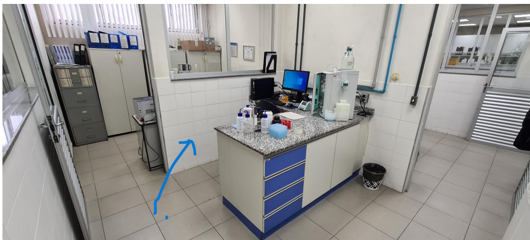
Parede a ser demolida
