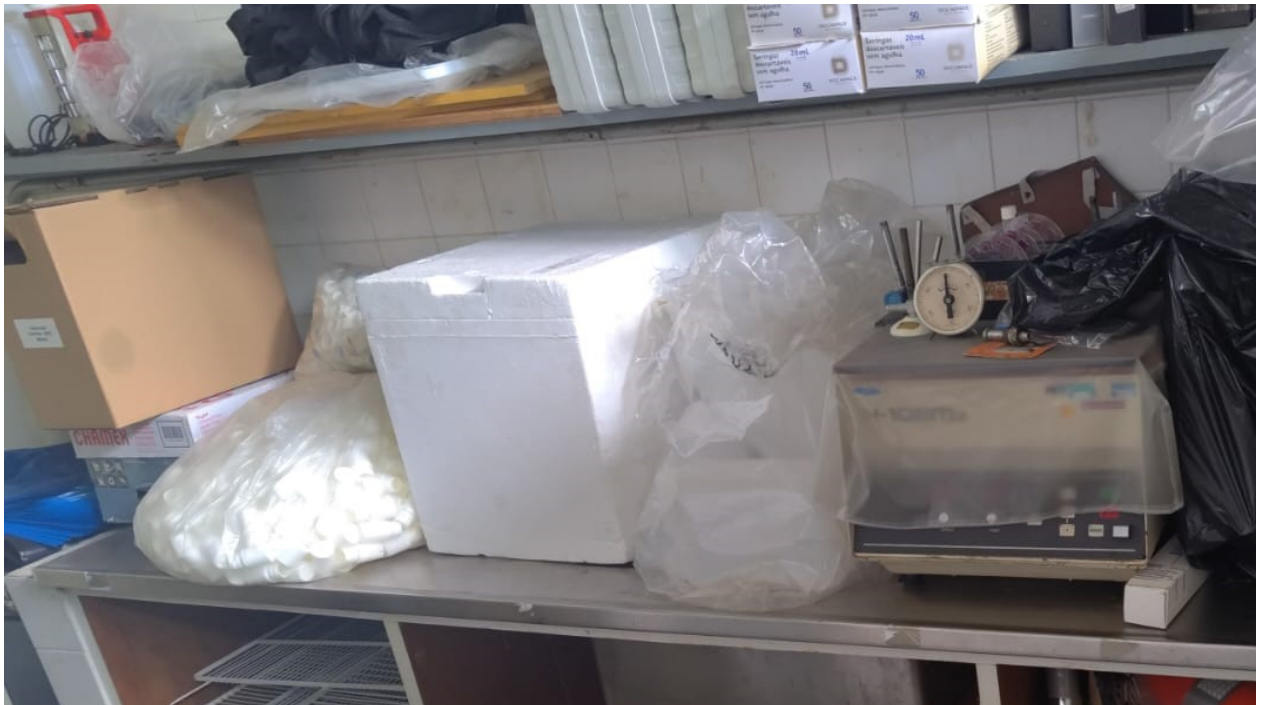
Foto Demolição e Retiradas: alvenaria, bancada inox, gabinete, base concreto, piso cerâmico, etc.
