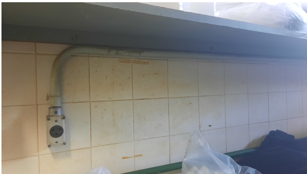
Foto:Demolição azulejo, prateleiras, etc.
